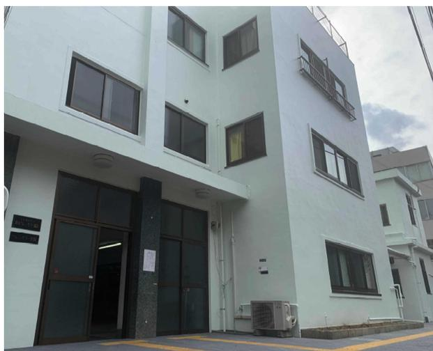
本館西側と東側一部の外壁を改修しました。塗装の劣化やコンクリート内部の鉄筋の腐食・膨張で亀裂が入るなど傷みが激しく、複数個所の雨漏りの原因にもなっていました。
